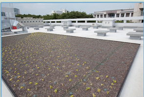
运用太阳能进行“屋顶绿化”
